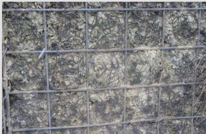
Erosionsschutzmatte beschädigt
