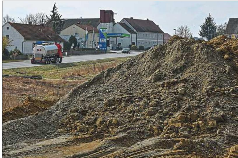
An der nördlichen Seite von Weichenried deuten hohe Erdhaufen bereits darauf hin, dass dort die Bauarbeiten für die Umgehungsstraße der B 300 weitergehen werden. Ab Donnerstag müssen Autofahrer wieder mit Umleitungen rechnen.
