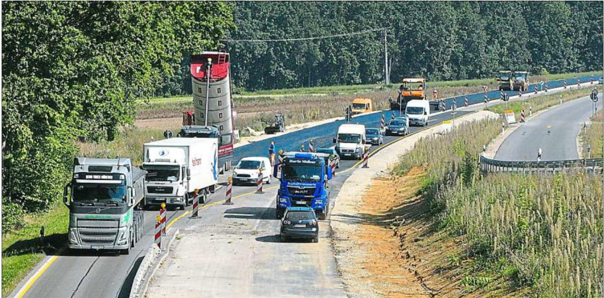
Die Arbeiten an der B 300 bei Weichenried liefen bisher ohne größere Behinderungen. So wurde vor zwei Wochen eine untere Asphaltsschicht asphaltiert, während der Verkehr nahe an der Baustelle vorbeifloss. Nun muss aber doch komplett gesperrt werden, damit die Asphaltdeckschicht gleichmäßig wird und länger hält. Foto: Hofmann
