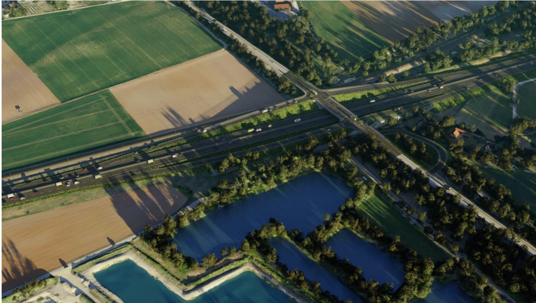
Knotenpunkt B 16 / Karlskroner Straße – Blickrichtung Nordosten
